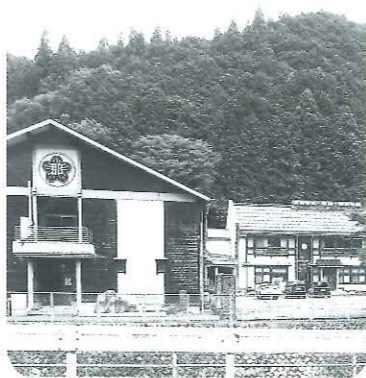
宿泊施設が整備される旧那岐小学校
