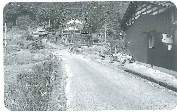
現在林道である屋並線 (那岐宮ノ本地内)
