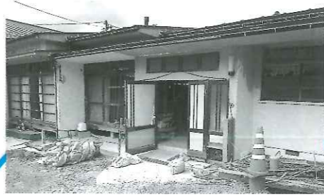
改修中の古民家(上町地内)
