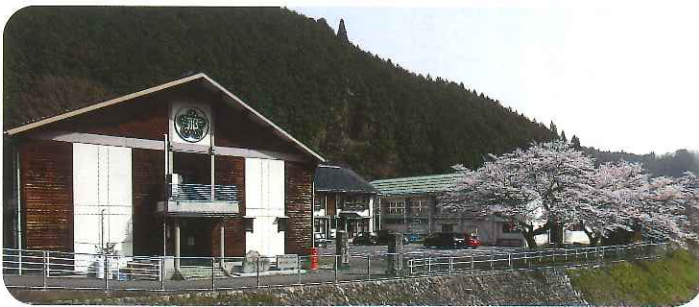
令和4年度中に、改築完成(外構を含む)を旨ざす旧那岐小学校。隣接するカフェ「タルマリー」の令和元年度来客数は約4万人で、宿泊希望者も多い。
