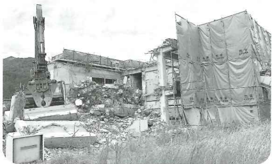
解体中の旧あたご保育園
