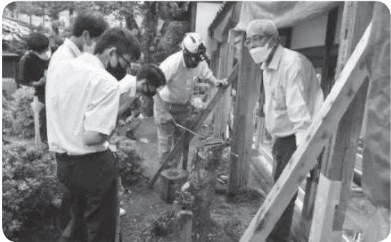
文化財の修理現場を見学
