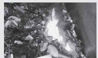
ごみ処理施設内での発火状況
