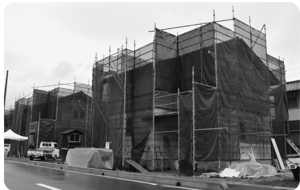
▲現在建築中（令和6年3月完成予定）
