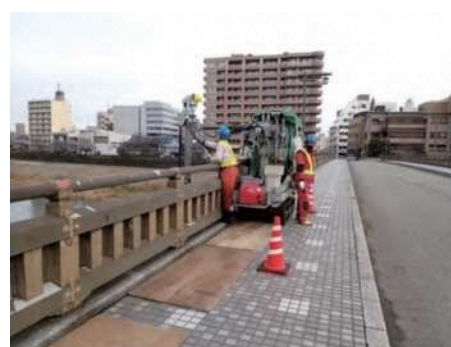
橋梁点検支援ロボットによる点検
