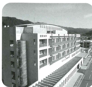
竣工まもない智頭病院(平成17年)
