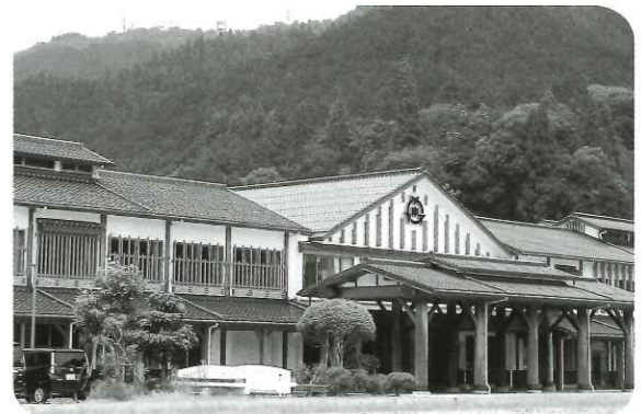
木造の智頭中学校校舎
