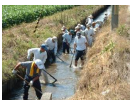
水路の泥上げ
