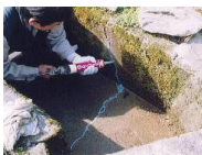
水路のひび割れ補修
