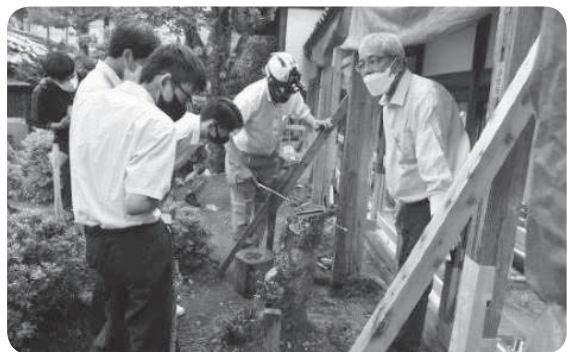
文化財の修理現場を見学
