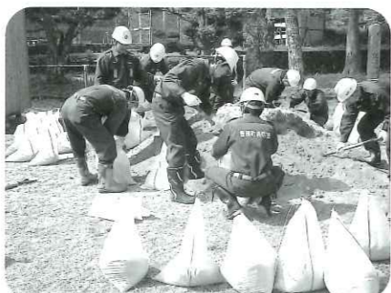
水防工法の基本土のう作り
