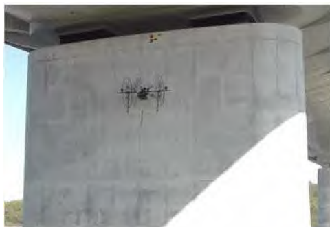
ドローンによる点検
