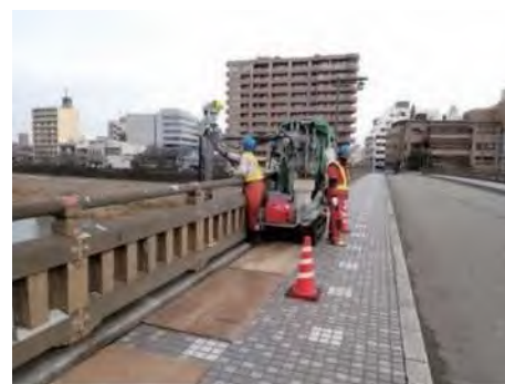
橋梁点検支援ロボットによる点検
