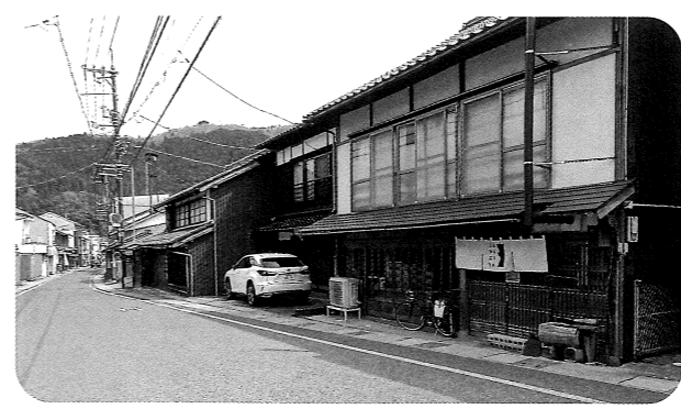
活用が待たれる改修中の空き店舗
