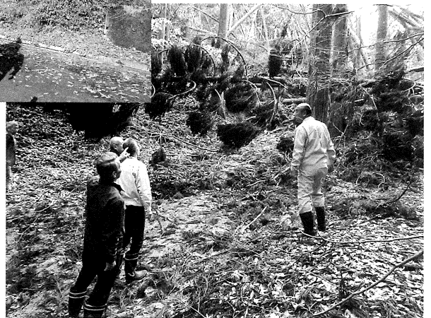
中原地内(天狗谷)の土石流出箇所を視察
