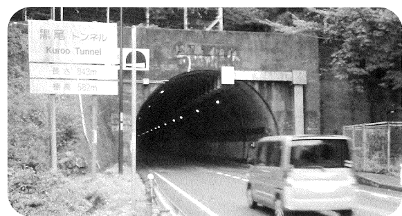
黒尾トンネル鳥取県側入口
