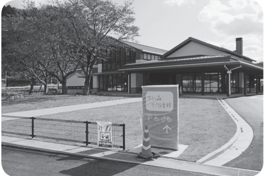
智頭駅側から見た図書館
