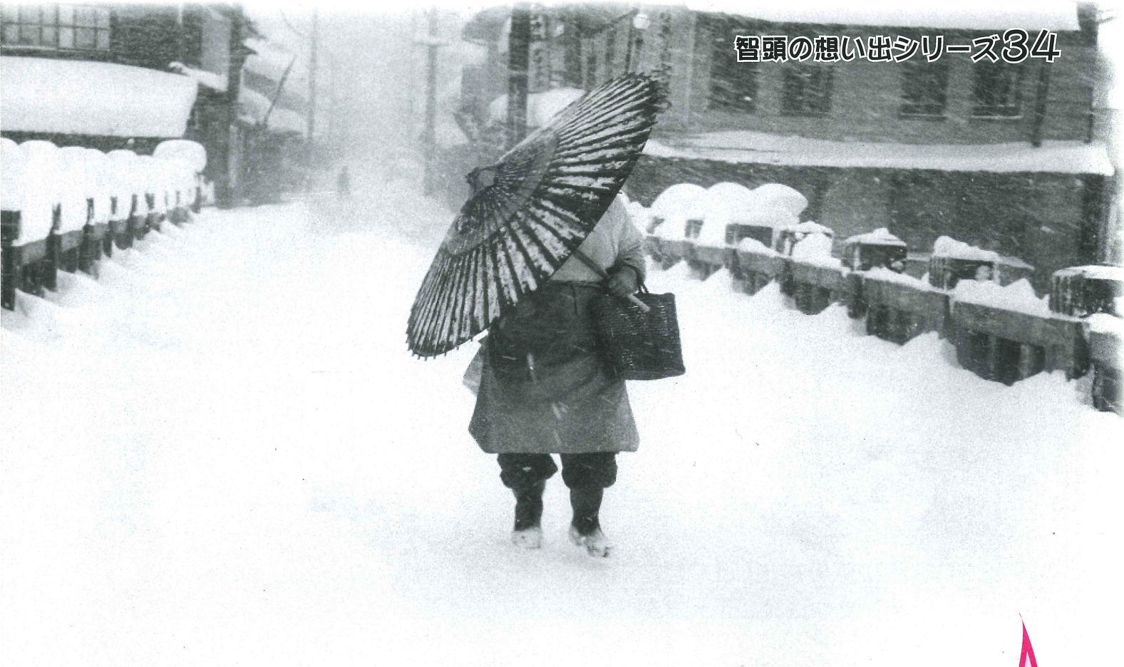
雪の備前橋上(昭和32年頃 中町方面を望む)
