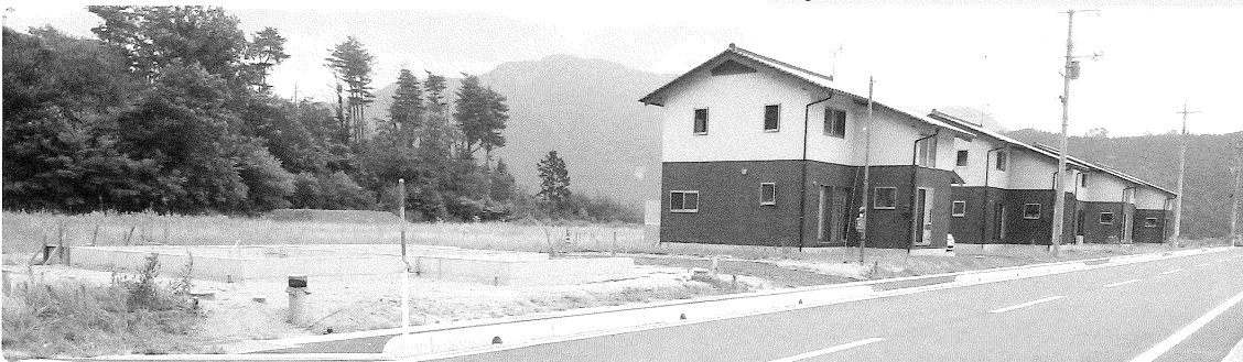
新築着工の定住住宅(ゆめが丘団地)
