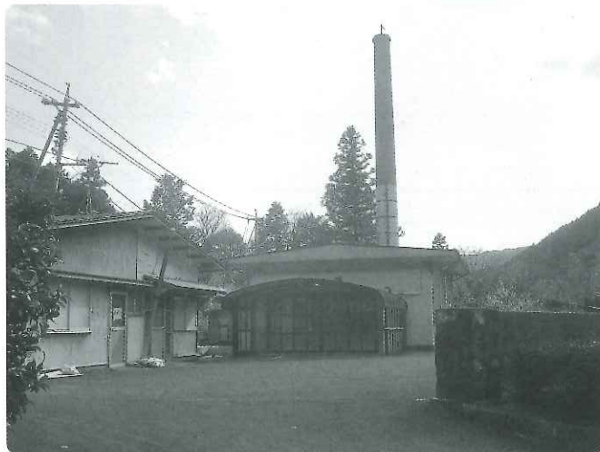
設置後50年以上が経過した町営火葬場
