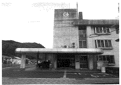
智頭町役場 正面玄関側
